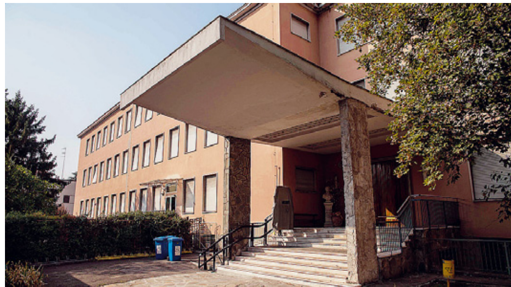
Da demolire La scuola Racagni verrà ricostruita ex novo dove si trova ora.
